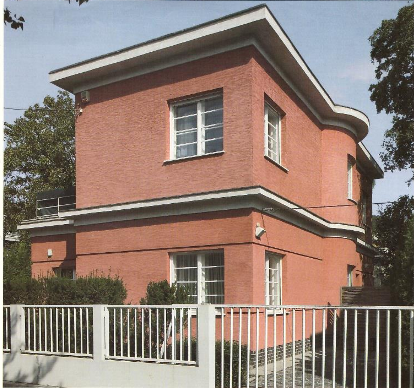
Napraforgó utca 7. szám, építész: Wellisch Andor
